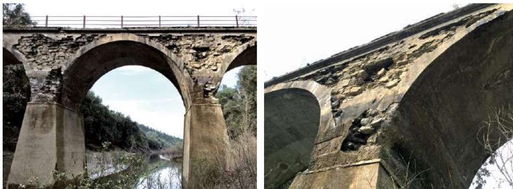
Le lesioni sulle pile sono, infatti, concentrate in corrispondenza dell'attacco degli archi e si estendono, in direzione verticale, fino alle fondazioni delle pile stesse, come si rileva dalla Figura 9. Le lesioni, che risultano in parte coperte dal materiale di rivestimento presente sulle pile, hanno un'ampiezza variabile tra 1 mm e 10 mm.
