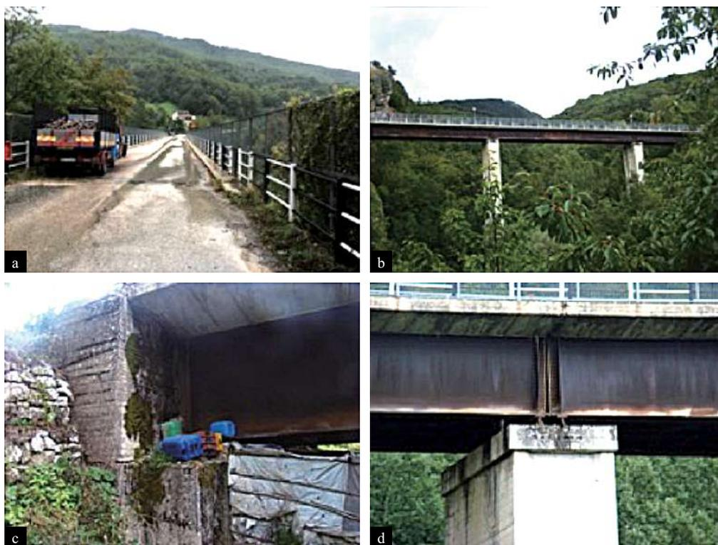
denza delle spalle; essi sono risultati integri e tali da garantire il normale utilizzo dell'infrastruttura viaria (vedi Figura 20). Per le pile intermedie le informazioni sono limitate in quanto non accessibili. Le spalle non presentano cedimenti e non vi sono segni di martellamento e/o perdita di appoggio.
